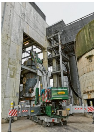
Mit einem Kran wurde der Vergaser nach der Demontage gehalten.
