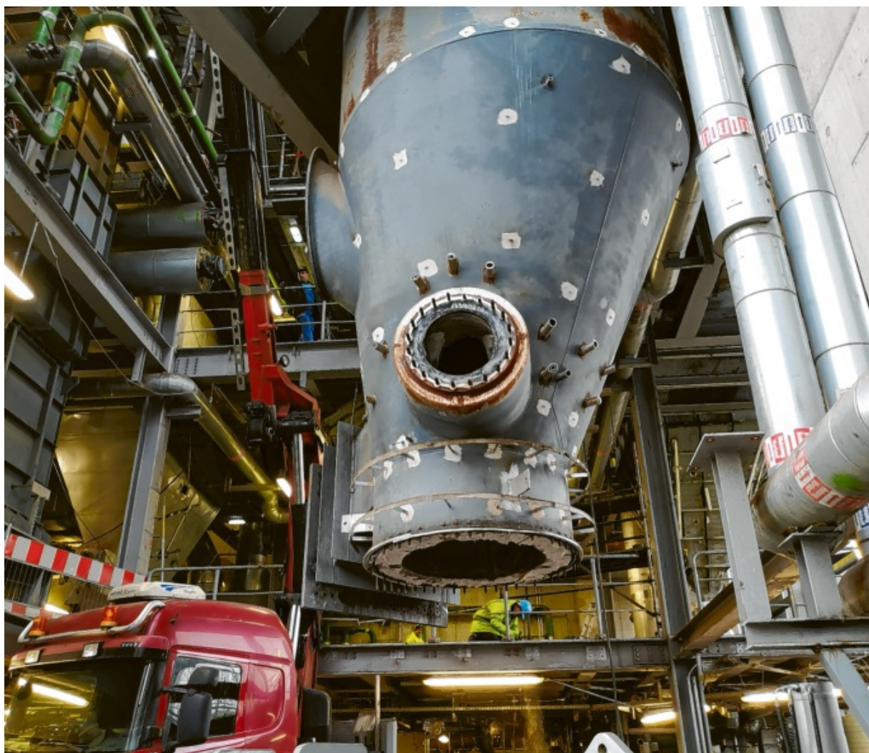
35 Millionen Euro steckten die Stadtwerke Ulm/Neu-Ulm (SWU) 2009 bis 2013 in das Sendener „Holzkraftwerk“. Das Herzstück, der 24 Meter hohe Vergaser wurde nun abmontiert und wird verschrottet. Fotos: Oliver Helmstädter
