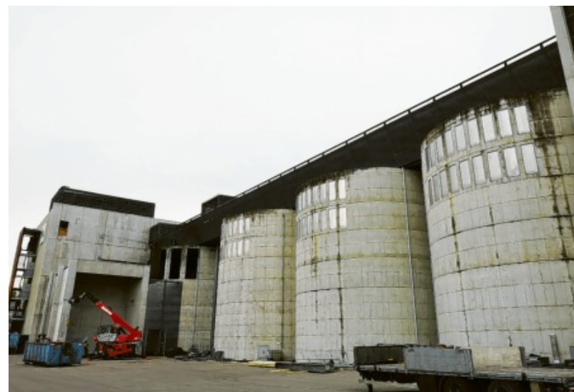
Prägend für das 175 Meter lange Gebäude sind die fast 14 Meter hohen Silos. Diese kann auch der neue Besitzer nutzen.
